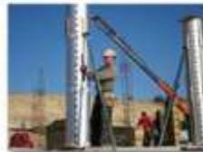
Заполнение опалубки бетонной смесью может быть осуществлено любым традиционным способом. Следует следить за тем, чтобы не повредить торцевой край опалубки, так как это может привести к расслаиванию внутренних ламинированных листов. Рекомендуется заливка по 1-2 метра.
