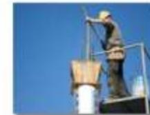
Когда бетон застыл, для раскрытия опалубки применяется стальной корд, расположенный внутри. Вытягивая корд, раскрываем опалубку на манер растягивания молнии. После контроля качества готовой колонны можно оставить опалубку на месте в качестве защиты от возможных механических повреждений в ходе дальнейших строительных работ.
